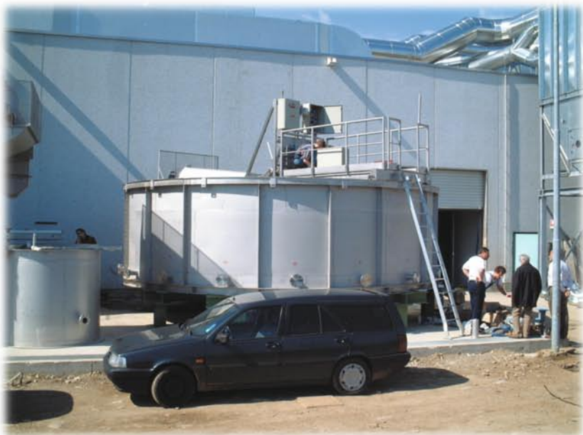
KLC 27 - Монтаж системы доочистки.
